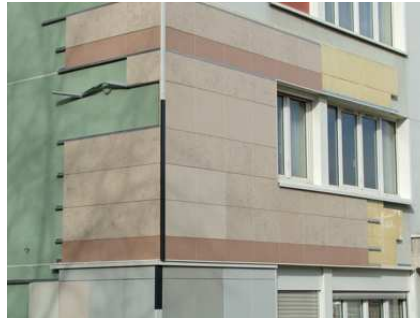
Pose d'isolation par l'extérieur sur un immeuble de logements, au Kremlin-Bicêtre – CAUE 94
