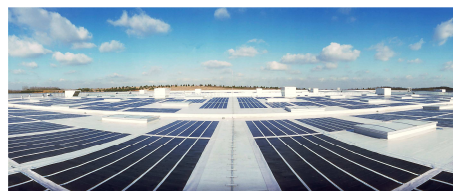
Photovoltaïque semi-transparent – Agence de l'énergie Val de Marne Vitry Photovoltaïque en par soleil – Photo Tecsol l'immeuble du CNRS à Perpignan Photovoltaïque amorphe - Photo Tecsol
