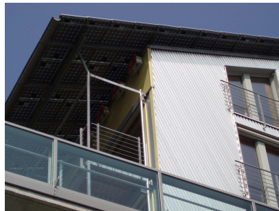
Brise soleil Source : Agence de l'Energie Val-de-Marne Vitry Débord de toiture : Quartier Vauban- Agence de l'Energie Val-de-Marne Vitry
