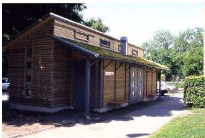
Local extérieur fermé à Malmö- Source : IBGE : Concevoir des dispositifs didactiques et ergonomiques de gestion des déchets
