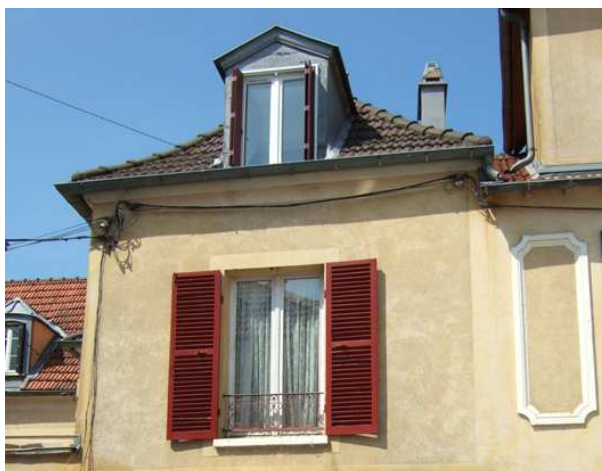
Maison, 9, rue Guy Mocquet, centre-ville, photo CAUE 94
