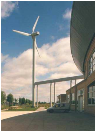
Eolienne à axe horizontale - Lycée Léonard de Vinci à Calais – Source : ARENE Ile-de-France
