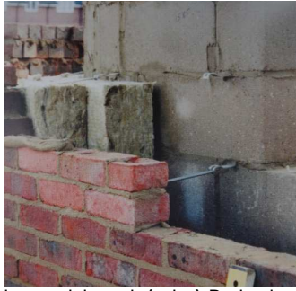
Isolation par l'extérieur en laine minérale à Bedzed – Christine De Buhan
