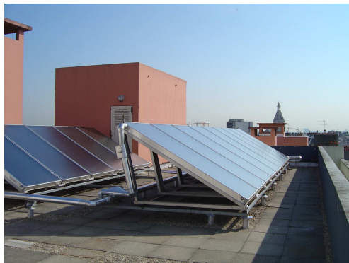
Chauffe-eau solaire collectif – Source : Paris Habitat
