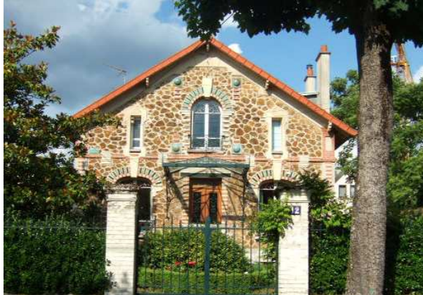
Exemple de maison en meulière dans le Vieux Val, photo CAUE 94
