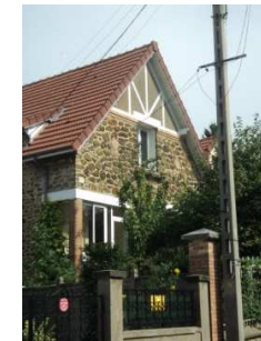
18 bis rue des Fontaines
