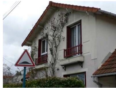
32 avenue du Petit-Val
