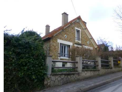
16 rue des Bouiards
