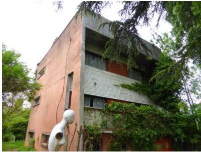
8 sentier de la Chaussée
