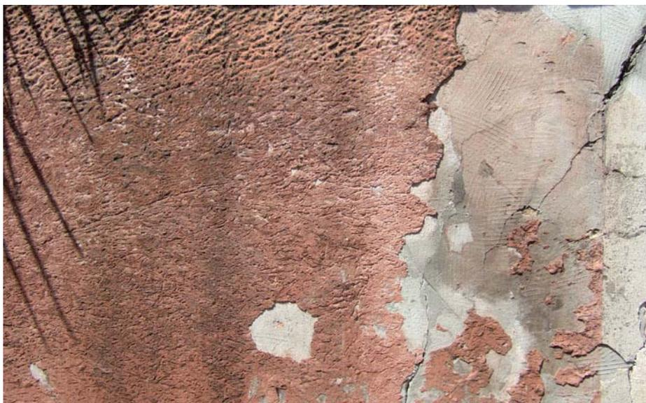
interdit toute respiration du support, les échanges gazeux se reportent sur l'intérieur des locaux, provoquant toutes sortes de défauts de surface, ou, à défaut, la capillarité continue son ascension dans les parois, jusqu'à une hauteur d'environ 1,20m à 1,50m au dessus du sol naturel.
