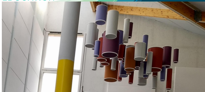
Luminaires doublés d'un système d'insonorisation à l'école du Plateau
