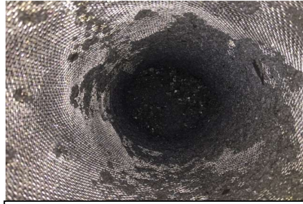
Intérieur du filtre colmaté
