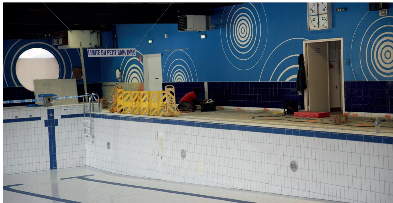
Réfection totale du bassin intérieur pour résorber les infiltrations, retirer la totalité du carrelage et le remplacer par un revêtement en résine. Réouverture prévue le 14 janvier.
