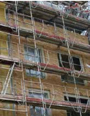
Détails de la façade
